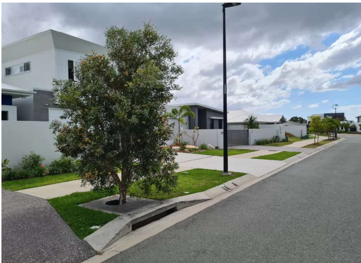
Thiết kế tích hợp thoát nước và trồng cây xanh đường phố.
